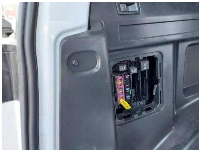
Abb. 3: Position des Sicherungsträgers im Laderaum links hinter der Verkleidung
