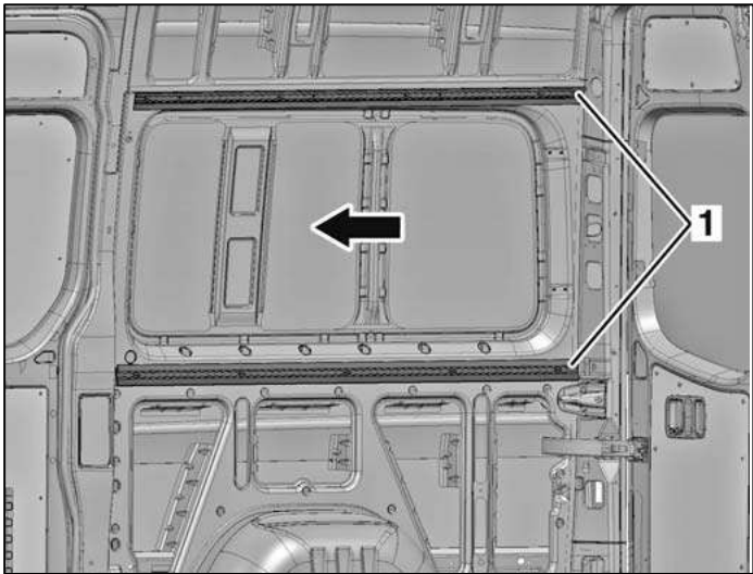
Несущие шины в фургоне
